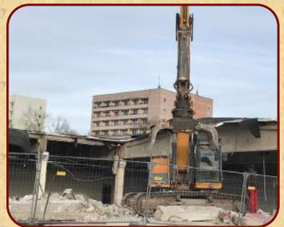
Die ehemalige "Kaufhalle" an der Marcel-Paul-Straße wird abgerissen und macht dem modernen Wohn- und Geschäftsgebäude "Panoramablick" Platz
