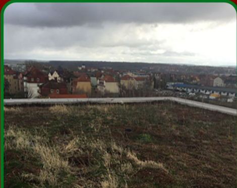
Der Standort des künftigen Taubenschlags auf dem Gebäudekomplex der Stiftung "wohnen plus..."
